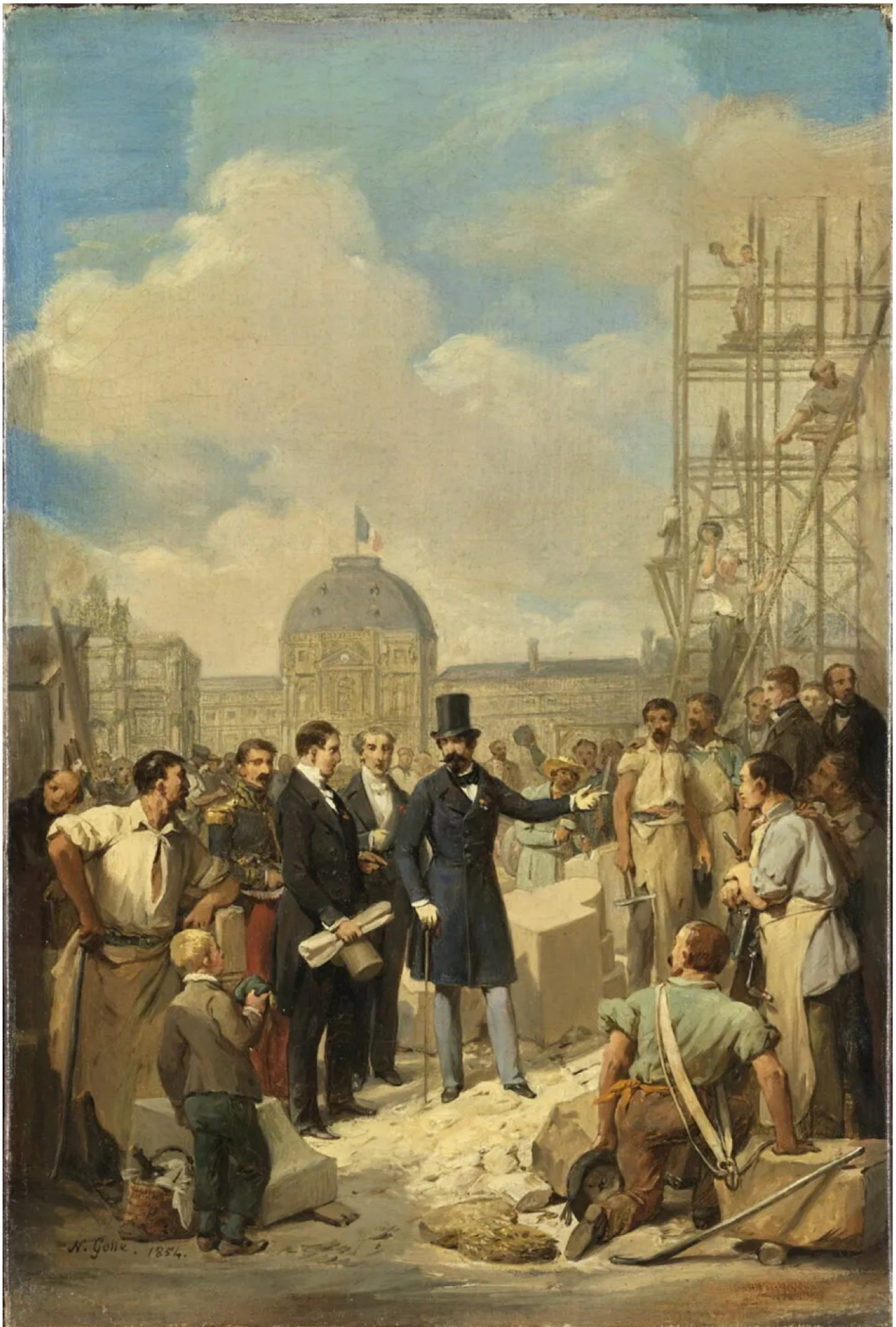
8. Napoléon III visitant le chantier du nouveau Louvre Nicolas Gosse (1787-1878) - 1854
