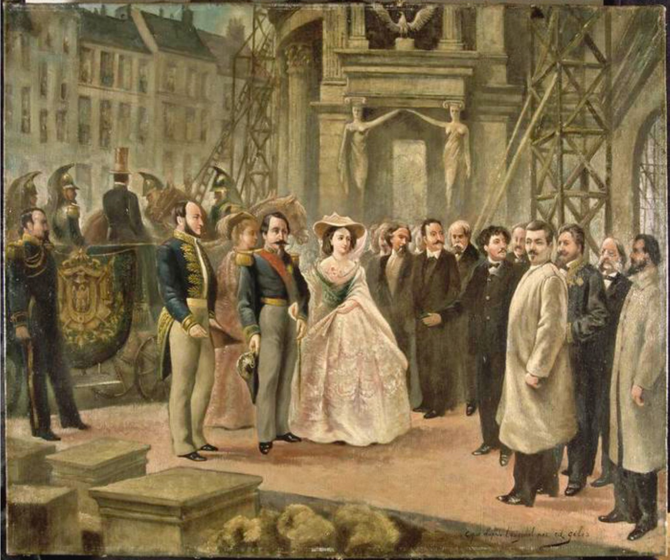
62. Edmond Gillis : Napoléon III et l'Impératrice visitent les travaux de l'Opéra ( Musée National du Château de Compiègne )
