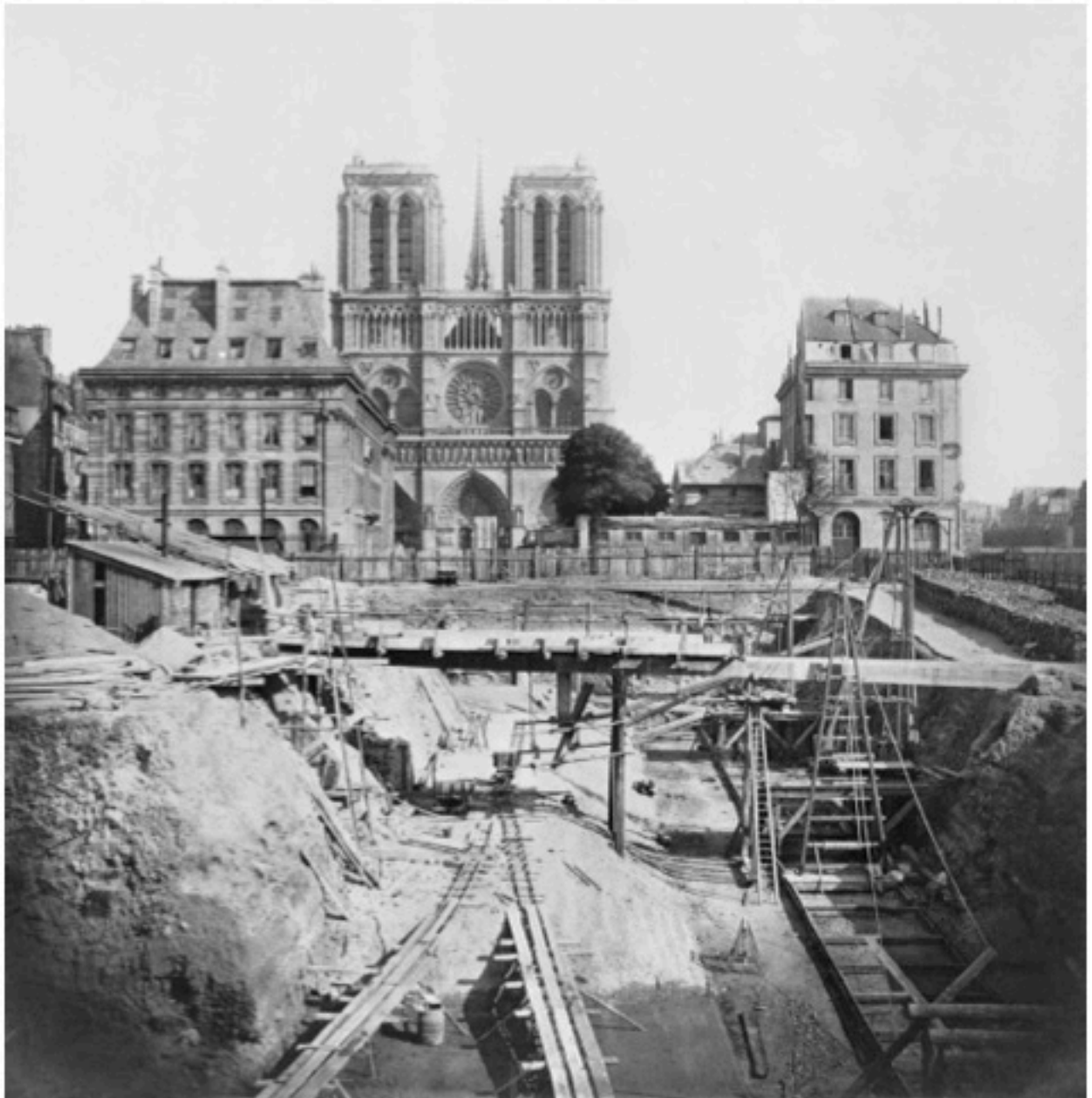
82. Pierre Ambroise Richebourg, (1810 -1875), photographe Travaux des fondations de la caserne de la Cité, île de la Cité avec Notre-Dame, 4ème arrondissement, Paris, Echaffaudages, cabane de chantier. - entre 1864 et 1865 - ( Musée Carnavalet )
